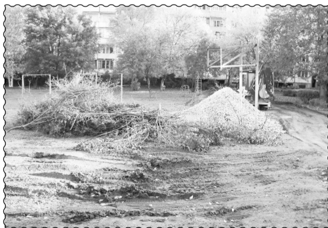
Благоустройство дворовой территории ул. Хохлова, д. 2-4
